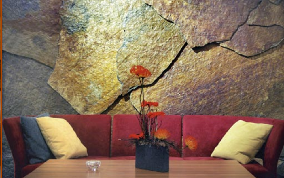
Veggkledning i Ottaskifer rust.
