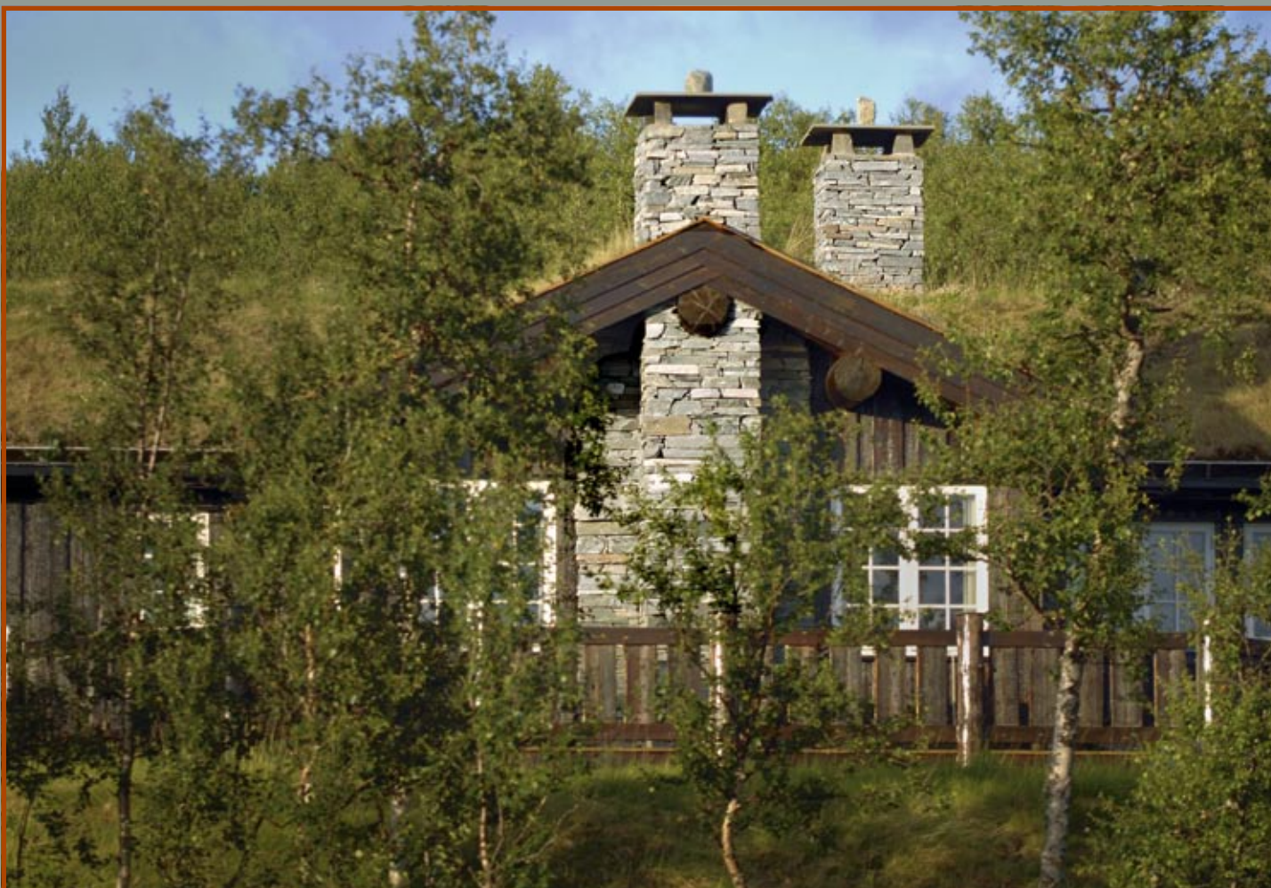
Tørrmur og pipeheller i Oppdalskifer.
